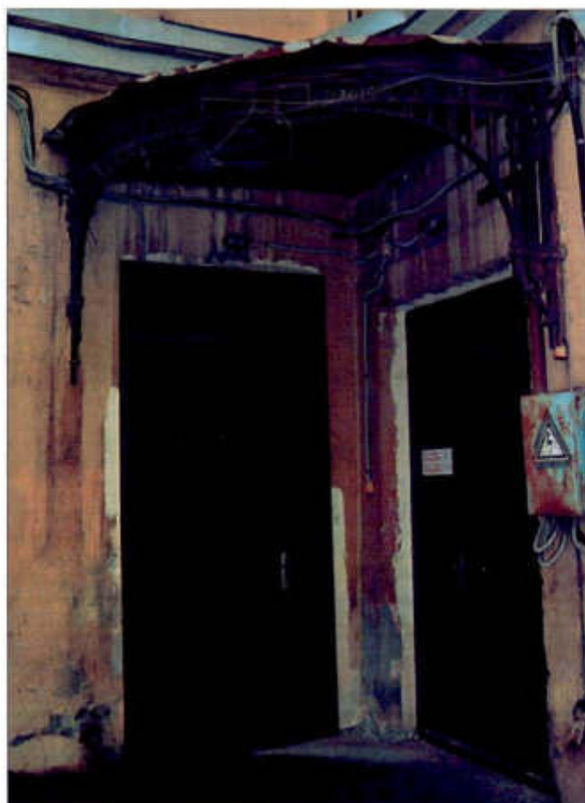
6. Исторический козырек над дверными проемами в западном дворовом корпусе.
