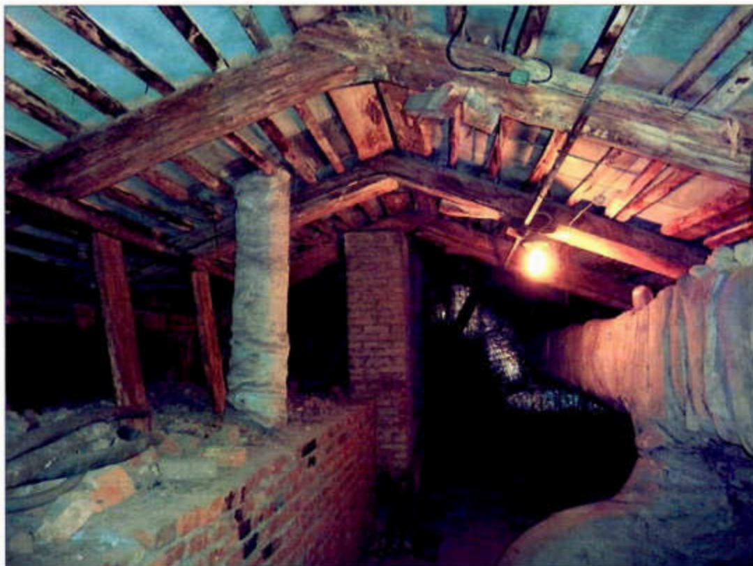
10. Чердак. Стропильная система.
