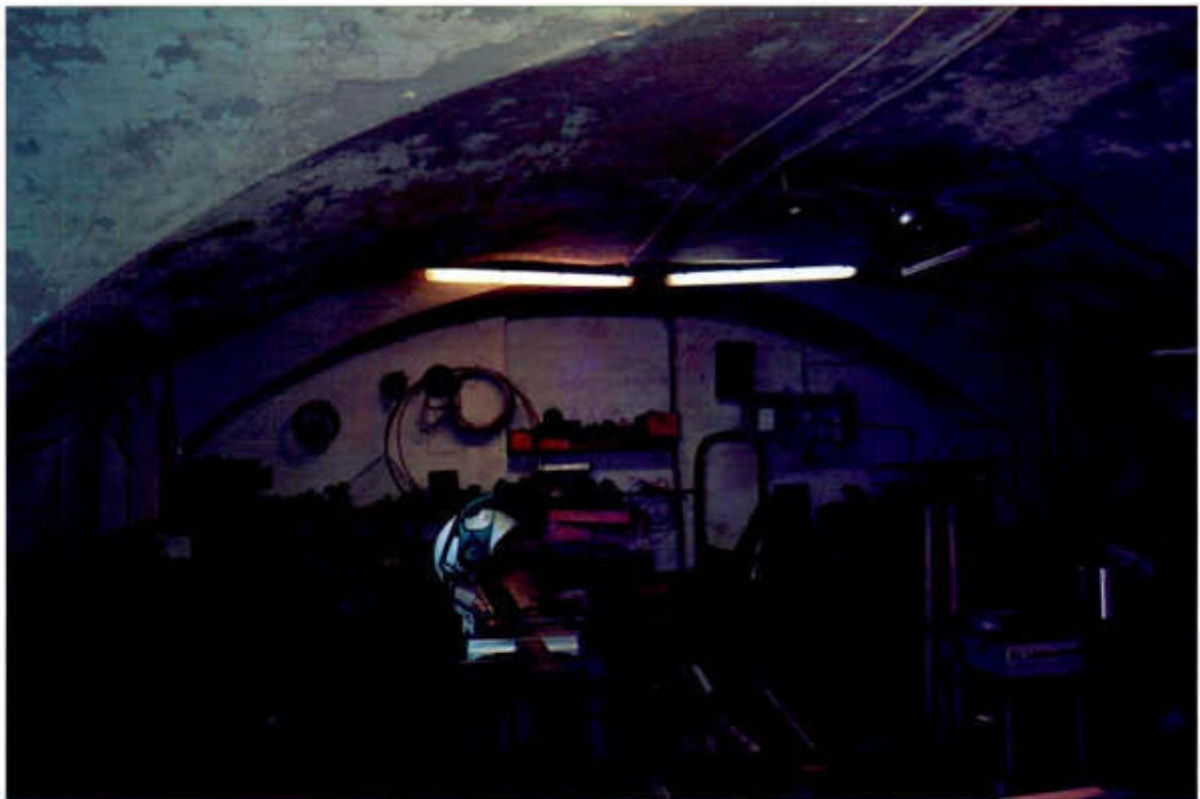
8. Коробовые с распалубками свода в уровне цокольного-первого этажа.
